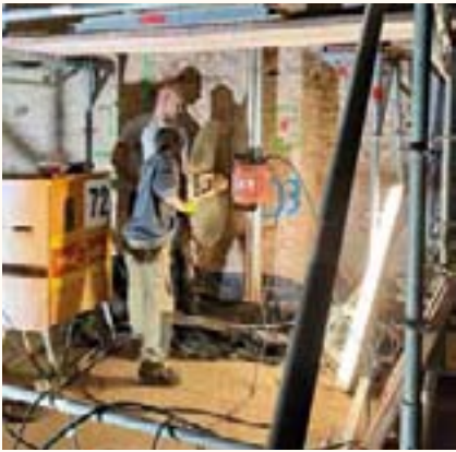
Mit einer speziellen Kreissäge werden die Schnitte in das Mauerwerk gebracht.
