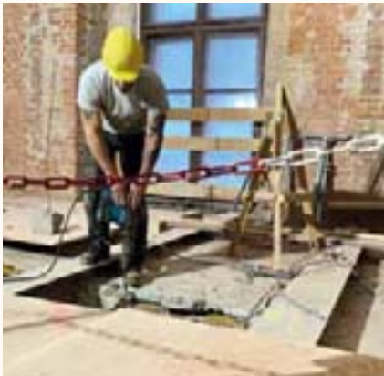
Die Füllungen zwischen den Stahlträgern werden herausgestemmt.
