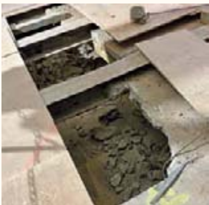
In einem zweiten Schritte werden die freigelegten Stahlträger herausgebaut.
