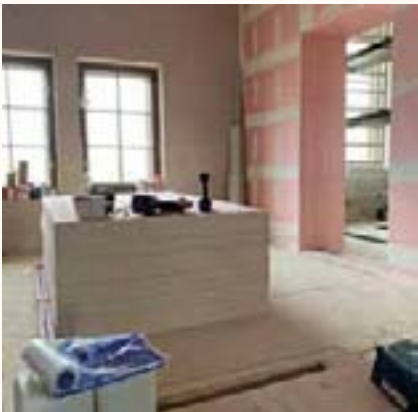
Im 6. OG hat der Trockenausbau begonnen. Hier sollen Büros entstehen.
