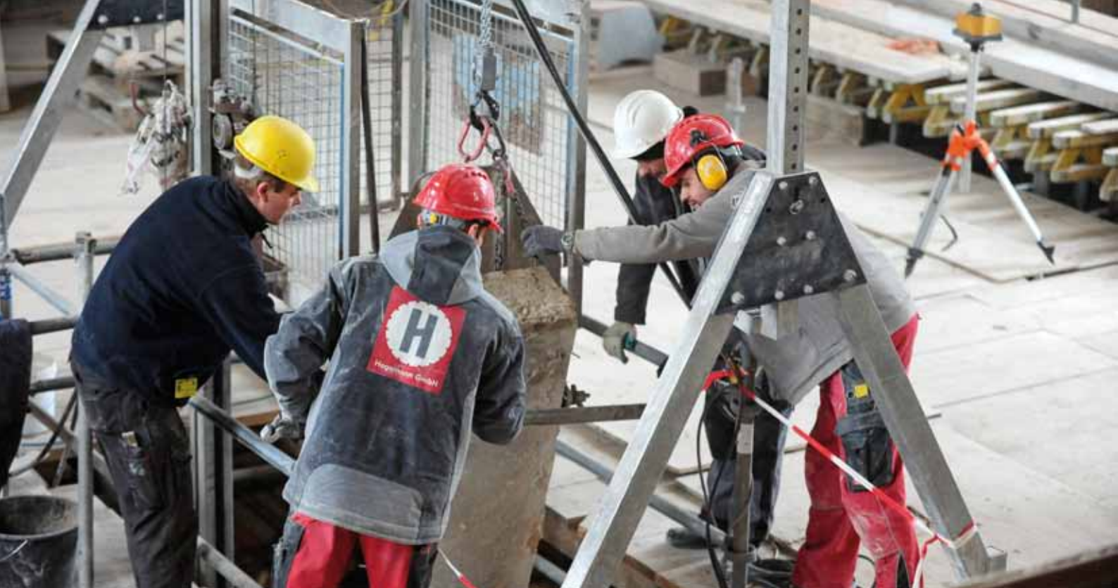
Für den Rückbau wurden mit der Hagemann GmbH und der Neumühler Bauhütte Firmen aus M-V verpflichtet.
