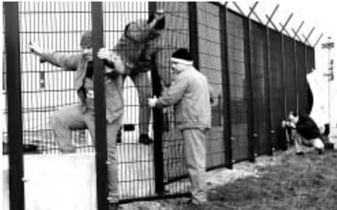
Seit Anfang Januar errichtet eine Firma aus Bargeshagen den G8-Schutzzaun.
